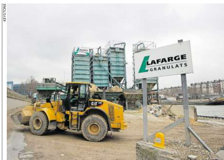
Lafarge-Baustoffe werden auf einer Baustelle in Paris eingesetzt.
